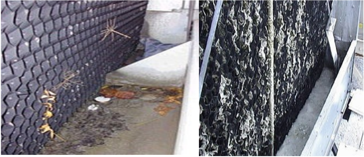
Şekil 4. Kule dibinde organik birikimler
