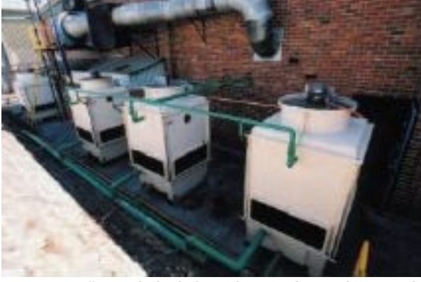
Şekil 1. Bir soğutma kulesi sistemin parçalarını oluşturan birbirine seri bağlı soğutma kuleleri
